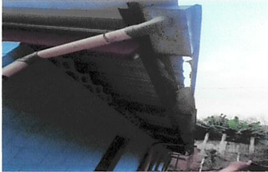
Foto 1: Colocación de canales y bajadas de agua.
