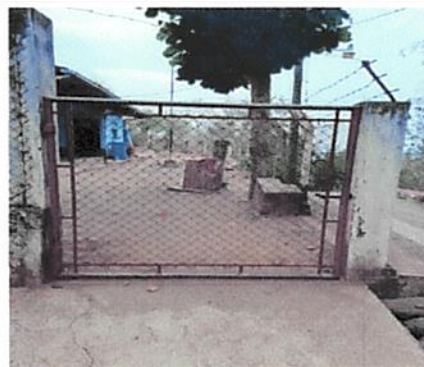
Foto 10: Reparación de portón de acceso.
