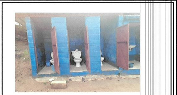
Foto 14: Reparación de sanitarios.
