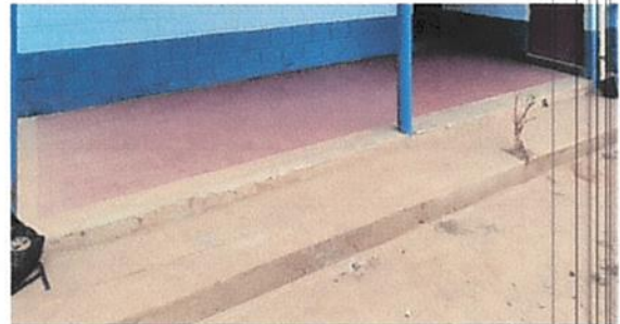
Foto 4: Instalación de piso cerámico
