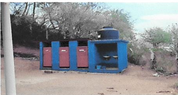
Foto 5: Instalación de rotoplast de 1,100 litros,
