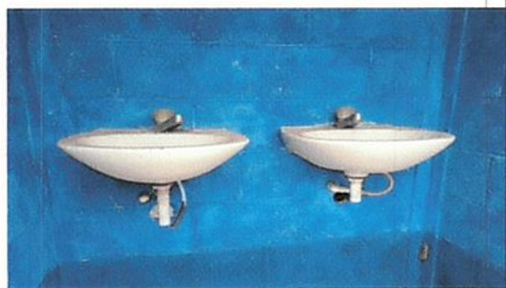
Foto 12: Mantenimiento de lavamanos
