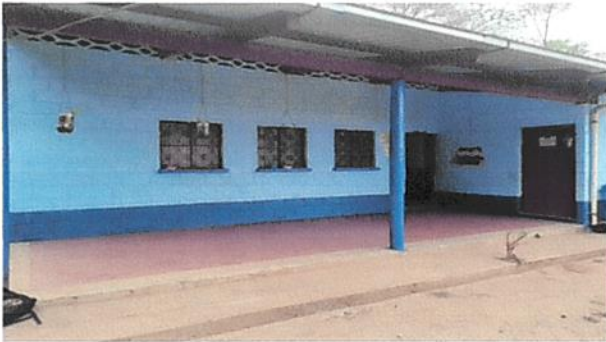
Foto 3: Mantenimiento de puertas de metal.
