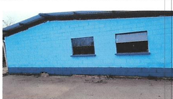
Foto 8: Instalación de ventanas de PVC.
