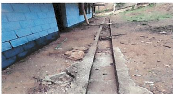
Foto 11: Nivelación de banqueta
