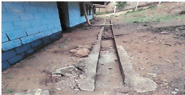
Foto 7: Restauración de cuneta de protección
